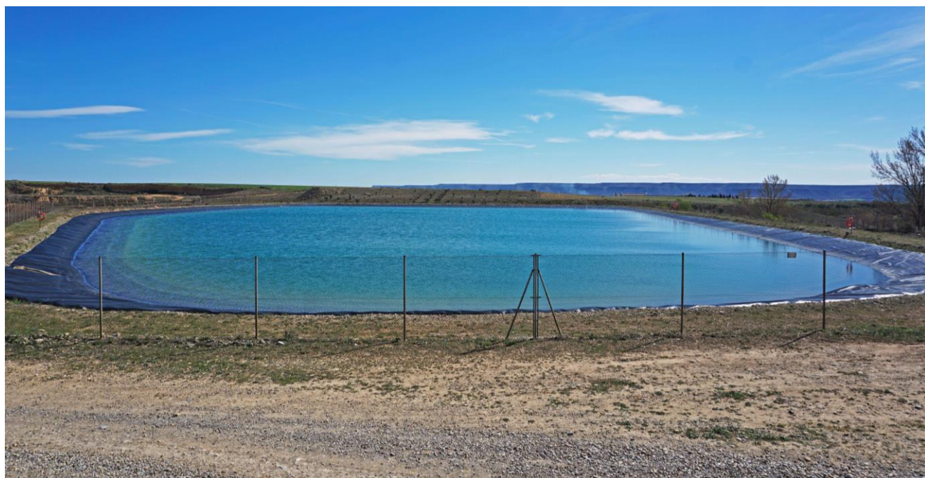
Bassa d'aigua potable del ajuntament de Saidí. Març 2018. Arxiu propi.
