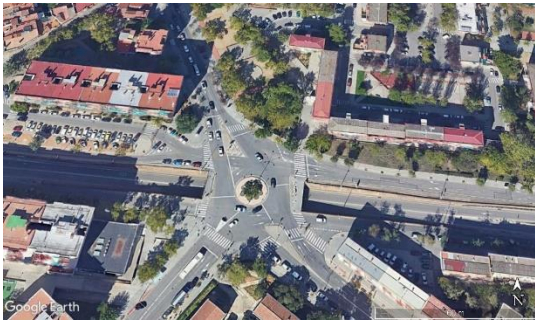
Av. Matadepera – Av. Concòrdia (pont 9)
