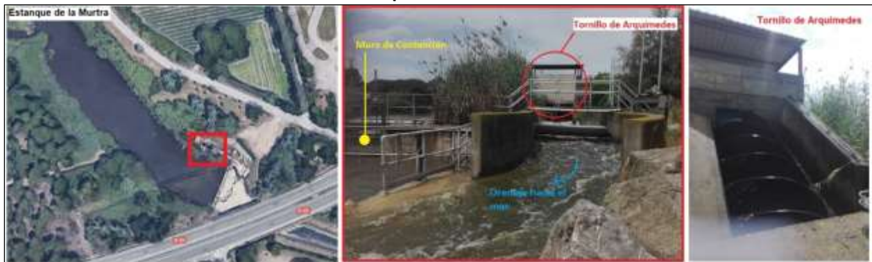
Figura 11. Sistema de drenaje en Estanque de la Murtra. Tornillo de Arquímedes en funcionamiento tras episodio de lluvia
