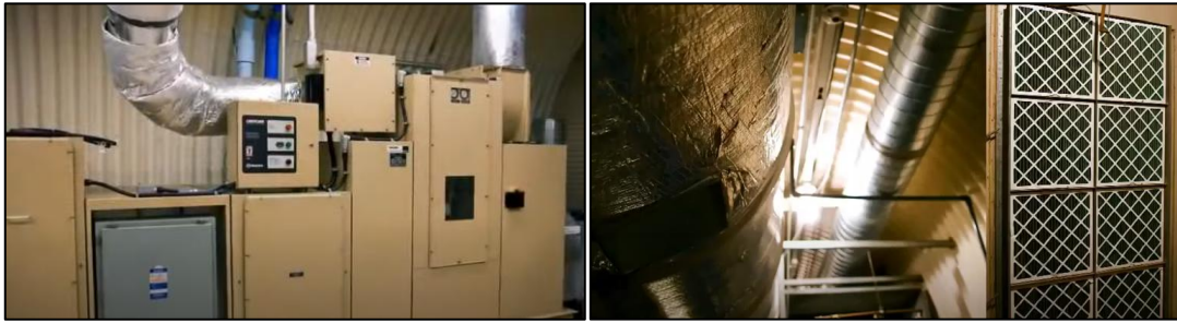
II·lustració 5. Sistemes de recirculació i filtratge de l'aire (Font: familysearch.org)
