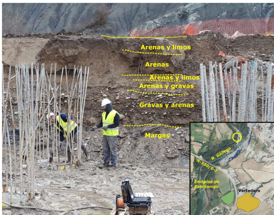
Figura 2. Materiales cortados en las excavaciones realizadas para las pilas del viaducto de la autovía A-23. (Fotografía cedida por la Demarcación de Carreteras del Estado en Aragón) [33].
