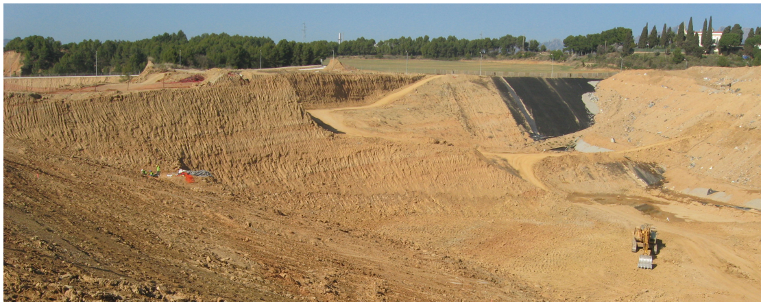
Imagen 4: Panorámica de las obras del vertedero de Can Mata (els Hostalets de Pierola). A la izquierda de la imagen se observa el yacimiento donde se encontraron los restos del nuevo hominoideo. Fuente: J.M. Robles / ICP.
