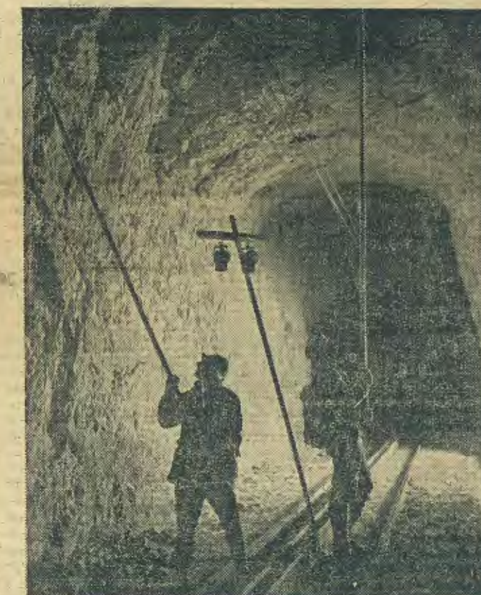
La inspecció d'un túnel
