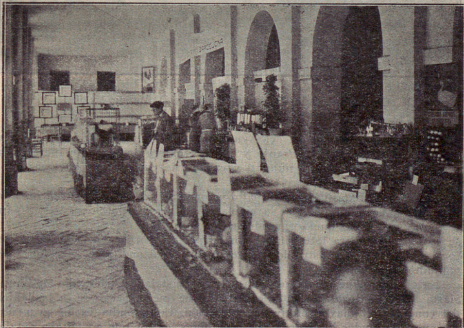
Detalle del interior de la instalación.
