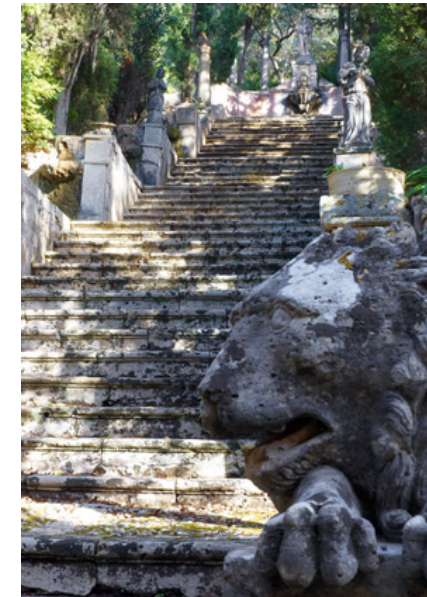
Figura 2.3.15. Escaleras de Raixa (Bunyola).
