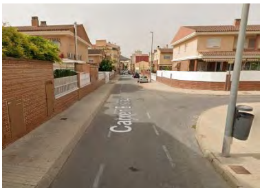
Petrer - Falta de separació del carril de bici
