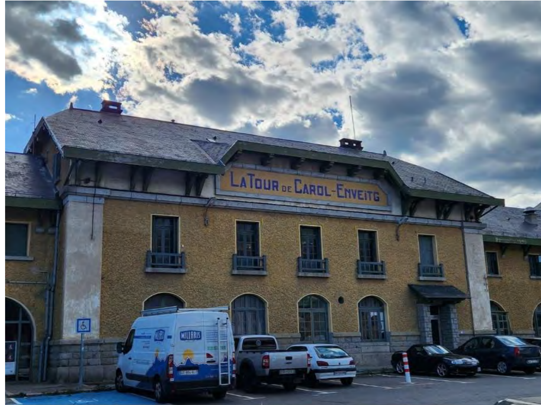
Font: Fotografia presa en treball de camp Metip a la Cerdanya setembre 2025
